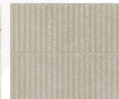
Pared de baños
